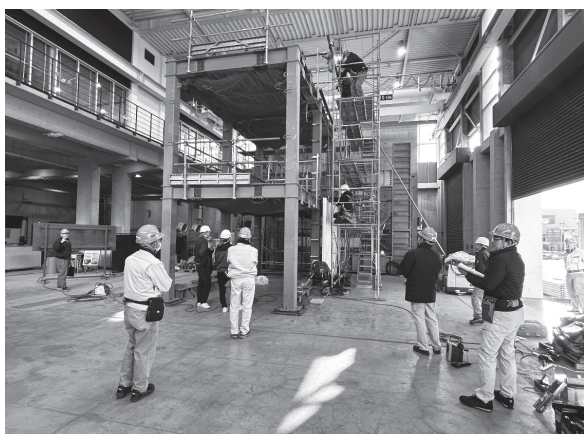
写真1 外装仕上および実習Ⅰ・Ⅱ (鉄骨工事+ALC工事+PCカーテンウォール工事の実大施工によるコラボレーションにより積算に対する応用力を育成する)
