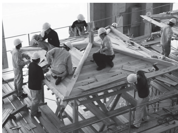
写真2 木造応用および実習 (柱四方転び・反り隅木入母屋造りの東屋の軸部の墨付け・刻み・組立により木造の積算に対する応用力を育成する)
