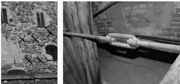
(d) フィンランド/石造のトゥルク城 (e) フィンランド: ボルボー市の教会の鐘楼造のトゥルク城の引き金物(ターンバックル)
