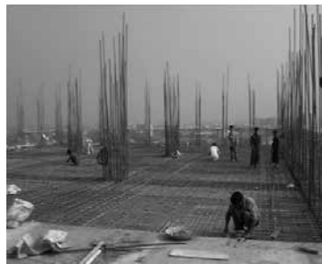
バングラデシュ現地工事現場
