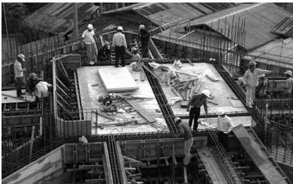
ラオスの工事現場ホッパーでのコンクリート打設
