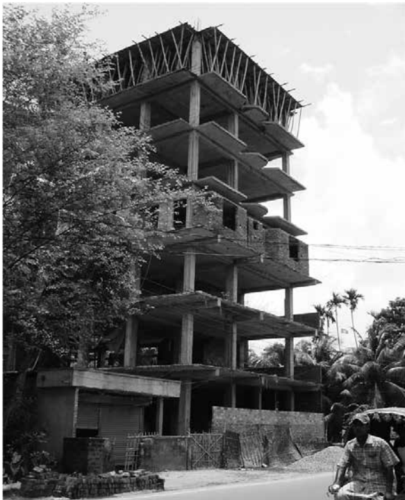
バングラデシュ調査 現地工事中建物
