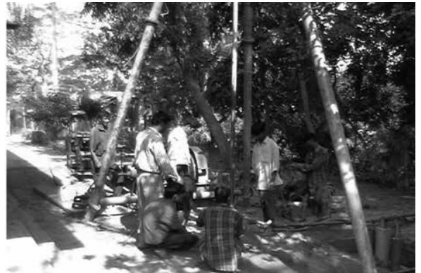
バングラデシュ現地ボーリング調査
