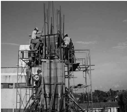
ラオスの工事現場ホッパーでのコンクリート打設
