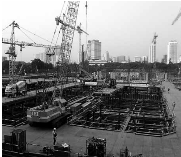
タイ国の工事現場
