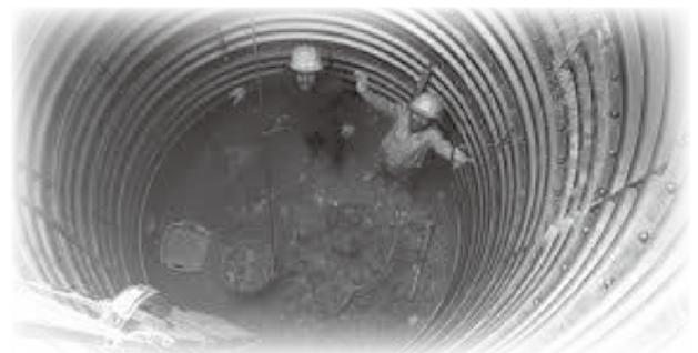
持層を確認し、杭径および拡底状況の写真を撮り、無事地上へ生還するというサイクルが繰り返される。天野には高所恐怖症の傾向がある。高いところから下を見ると、お尻の穴の周辺がゾクゾクする。杭の底も、地上から26m、床付から13mあるのだから、感覚的には高所となり、底へ降りてまた上がってくるという行為はかなり意志力を要するものだった。杭の底(2~3m程度)で拡底したむき出しの土とポタポタと滴る水を見てから、小さな穴となった地上を見上げると、一刻も早く地上に戻りたいと思えてくる。
